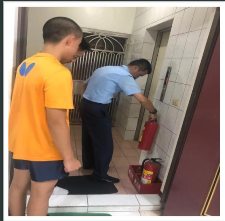
檢查消防設備
