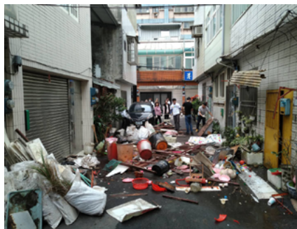
▲ 居家修繕 - 清除三大車廢棄物。
