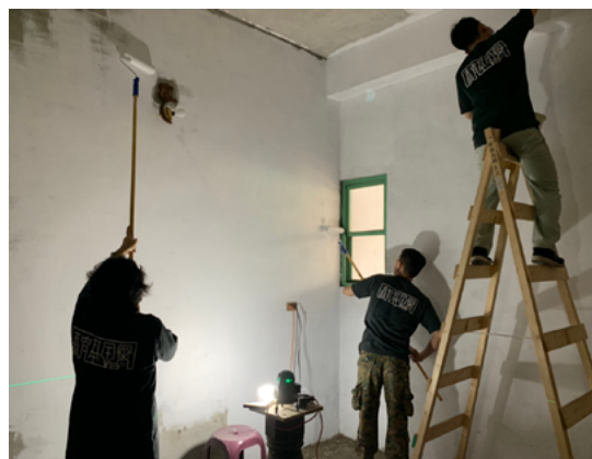
▲ 居家修繕 - 牆面粉刷。
