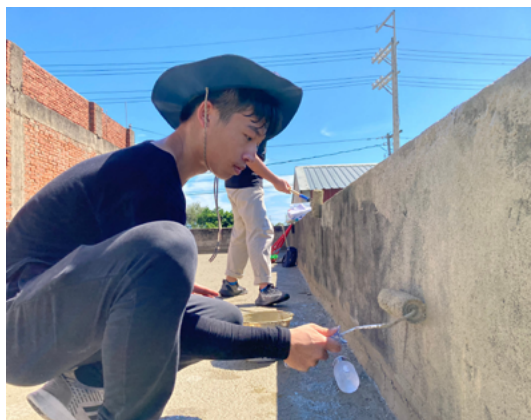
▲ 居家修繕 - 頂樓防水工程。
